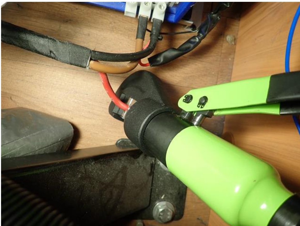
Crimpatura della giunzione di testa per prolungare il cavo della BM
