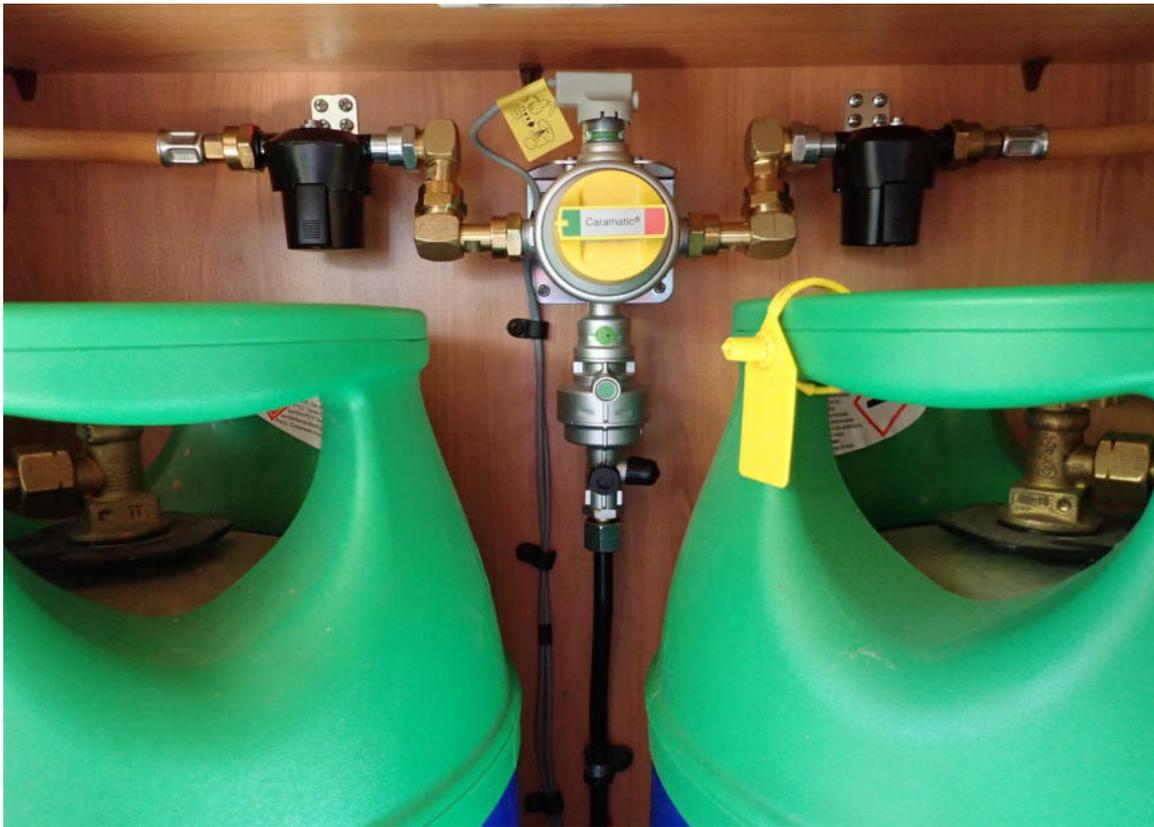
Installazione finale, notare i due filtri spostati in alto
