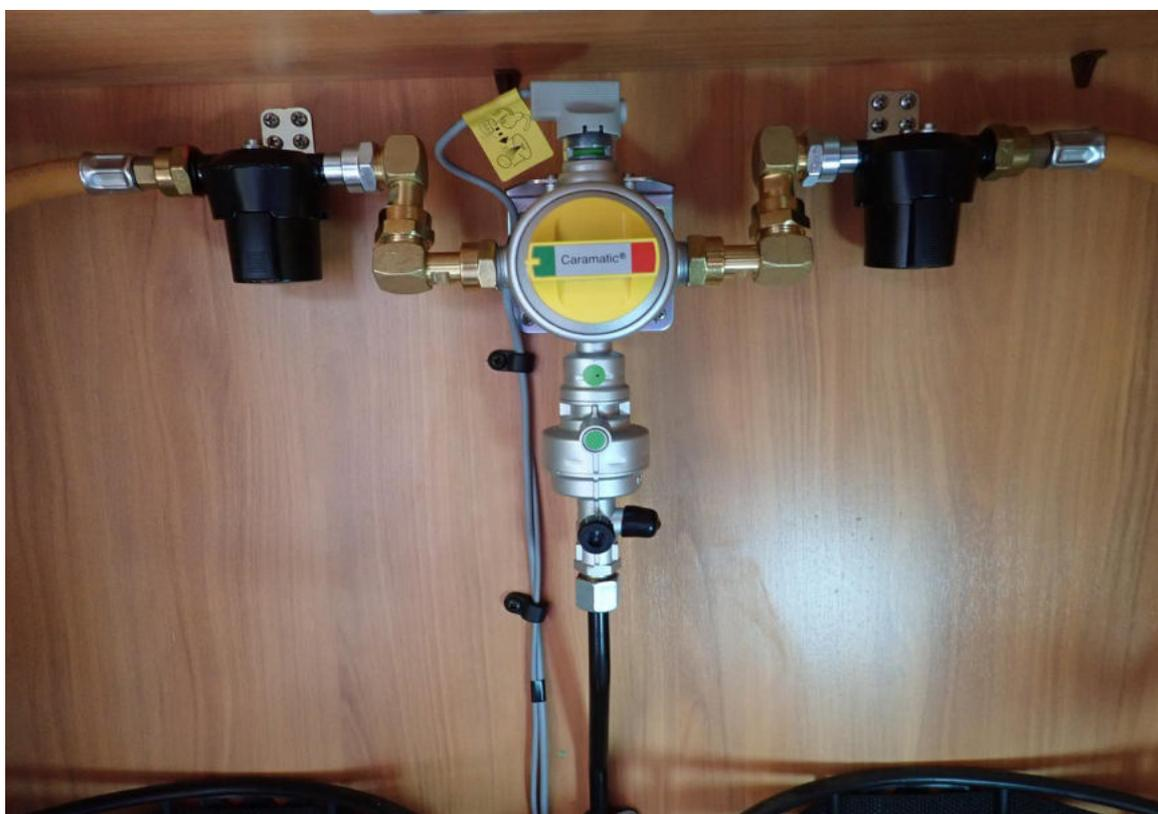
GOK Caramatic Drive Two CS installato nel vano bombole assieme ai due filtri TRUMA
