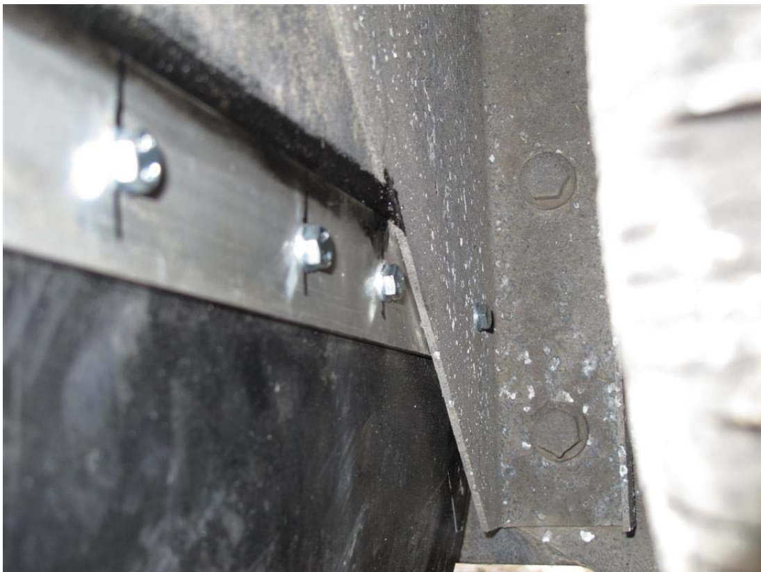
notare il bullone più interno che attraversa anche un rinforzo del telaio
